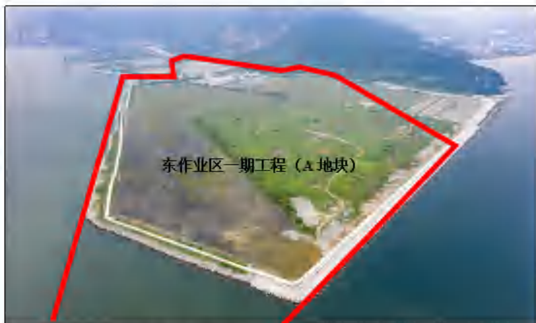
图 3.4-3 本项目（东作业区一期工程）现场图片
